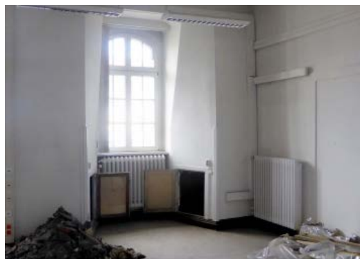
Ein Gästezimmer vor und nach dem Umbau
